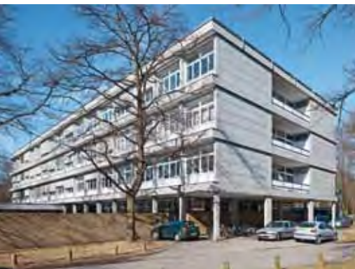
Gebäude 30.10, Nachrichtentechnik: energetische Sanierung der Außenhülle
