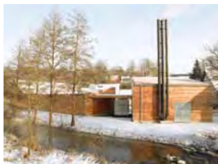
Marbach, Neubau Heizzentrale im Wirtschaftshof
