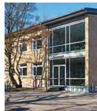
Gebäude 40.21 und 40.22, Boden- und Felsmechanik: Sanierung der Fassade
