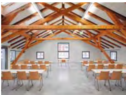
Marbach, Umbau Schulungs- und Informationszentrum
