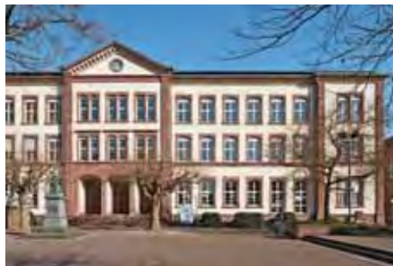
Gebäude 10.91, Maschinenbau: energetische Sanierung der Außenhülle
