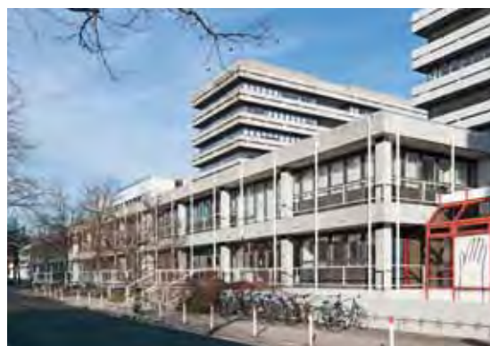
Gebäude 30.41, Chemiefachbau: Sanierung der Hörsäle und Büros
