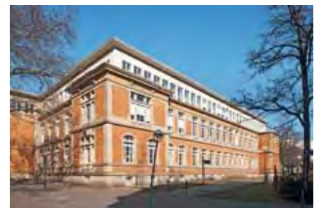
Gebäude 20.40, Fakultät Architektur: Sanierung der Fassade und des Daches
