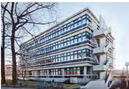
Gebäude 20.20 und 20.21, Rechenzentrum: Austausch von Fenstern und Sonnenschutz
