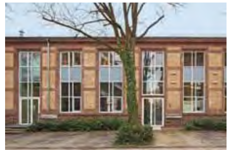
Gebäude 10.92, Maschinenbau: Sanierung Laborgebäude und Fassade
