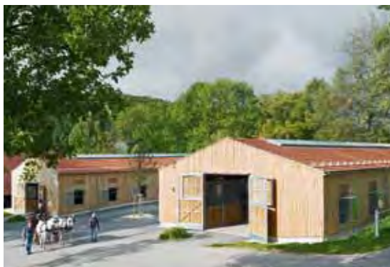
Marbach, Neubau Lehrgangsstall
